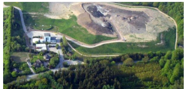
Abb. 1: Zentralmülldeponie Rastorf im Kreis Plön (S-H), Deponieklasse II mit einer Größe von ca. 10,5 ha
