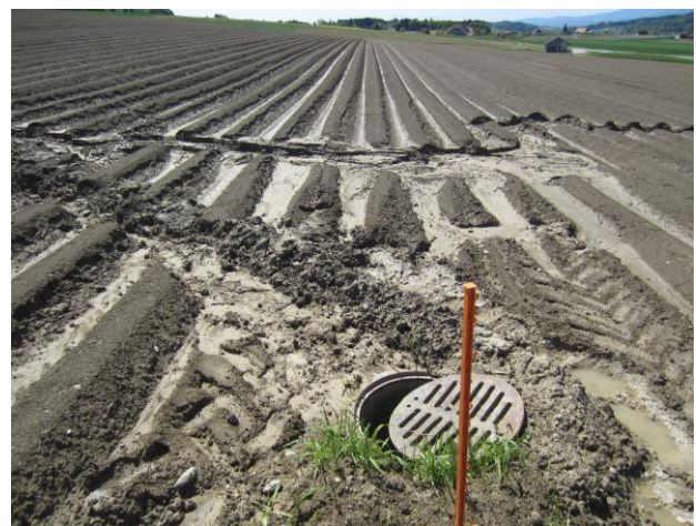
Abb. 2: Einlaufschacht über einem eingedolten Bach mitten in einem von Erosion betroffenen Kartoffelfeld.
