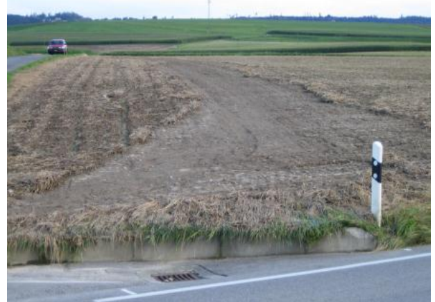
Abb. 1: Breite Erosionsrinne, die direkt auf einen Einlaufschacht einer entwässerten Straße führt.
