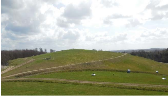
Abb. 1: Zentralmülldeponie Rastorf im Kreis Plön (S-H), Deponieklasse II mit einer Größe von ca. 10,5 ha.
