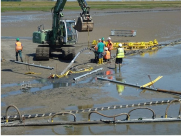
Abbildung 1 Baustelle eines Seekabelanschlusses mittels Horizontalbohrung vor Borkum (Foto: Schumann 2013)
